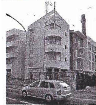
Gli alloggi di via Conte Rossi
